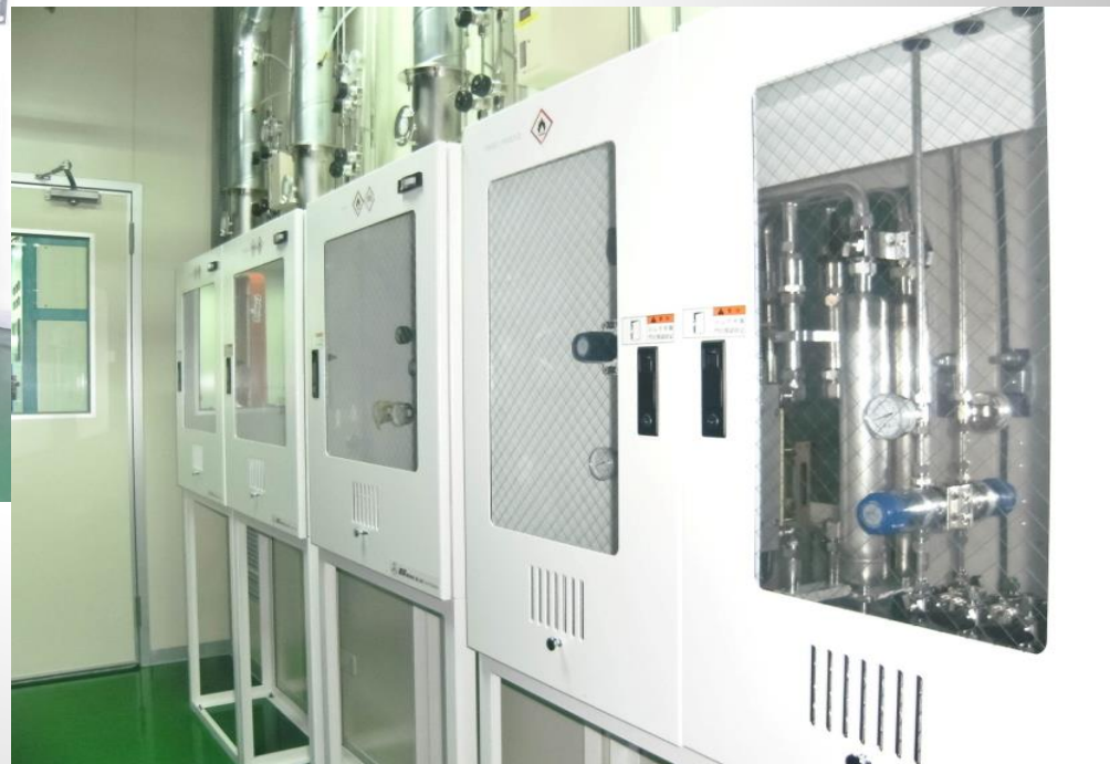
VMB配管工程
