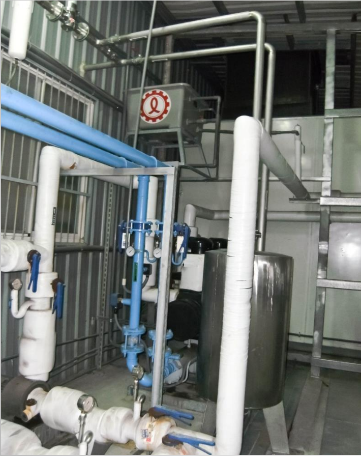
機房冰水管路工程
