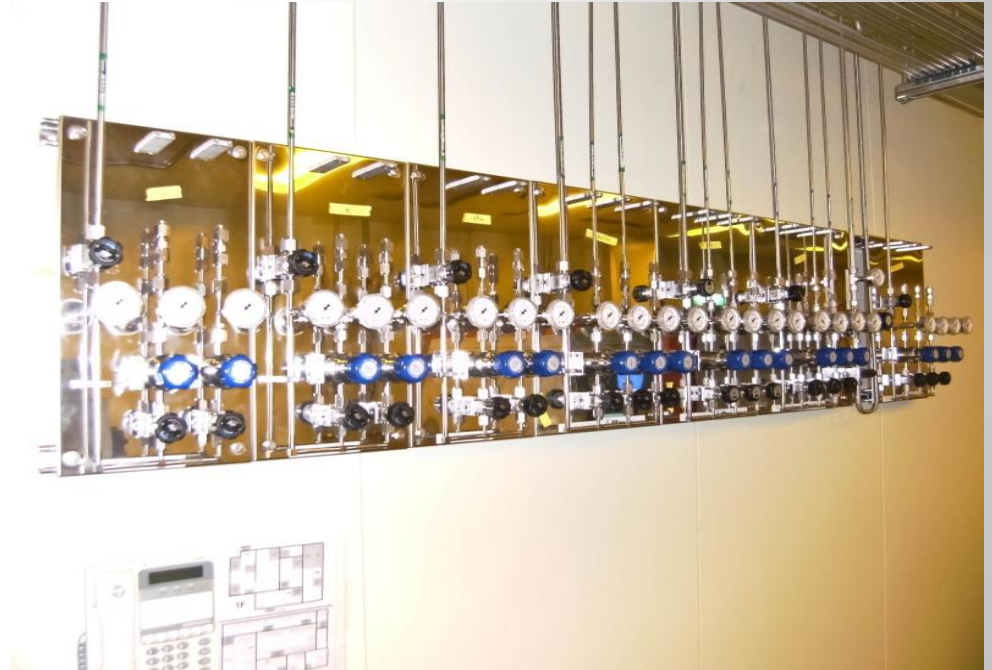
VMP配管工程
