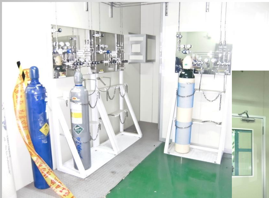
Ruck架配管工程
